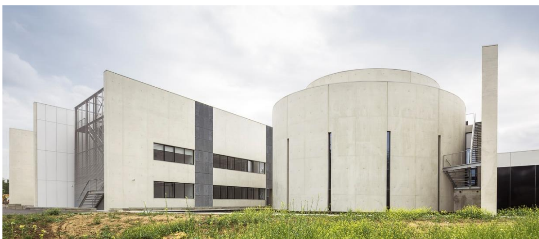
Voiles de béton cintrés - Centre R&D Air Liquide - Architecte Michel Rémon & Associés - Photographe : Sergio Grazia
