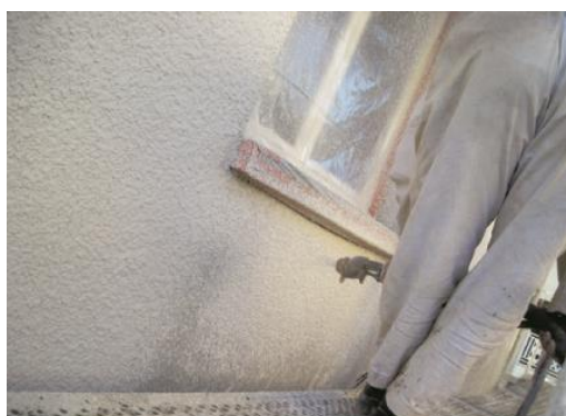
Application de Parinter Rénovation à la machine à projeter
