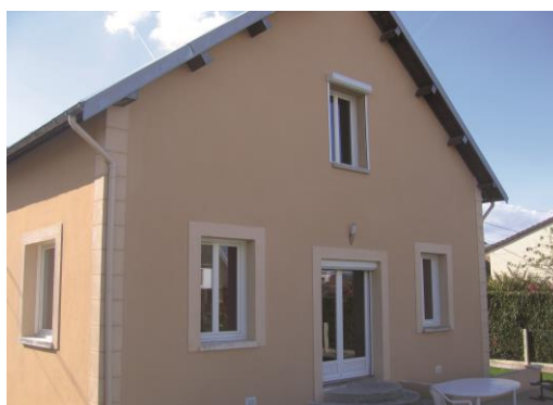
Un chantier de rénovation rapide et sans nuisances
