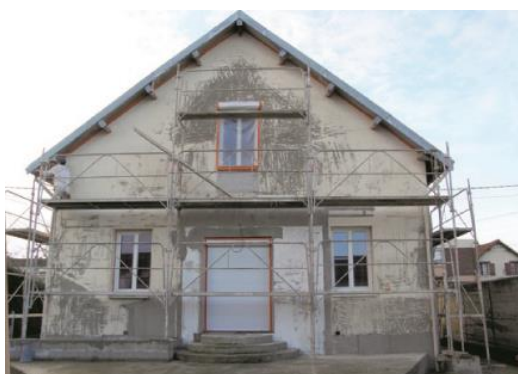
Nettoyage et traitement des fissures
