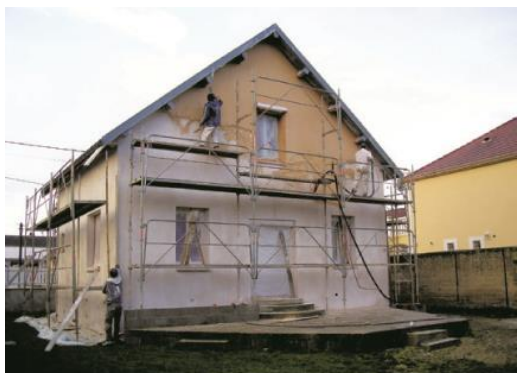
La couche de finition est réalisable 24h après l'application de Parinter Rénovation
