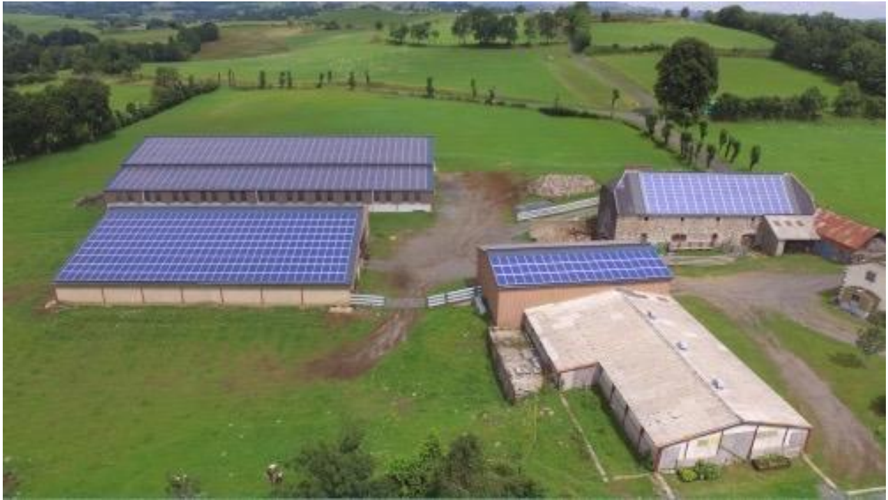
IRFTS EASY ROOF EVOLUTION, installation sur plusieurs corps de ferme.
