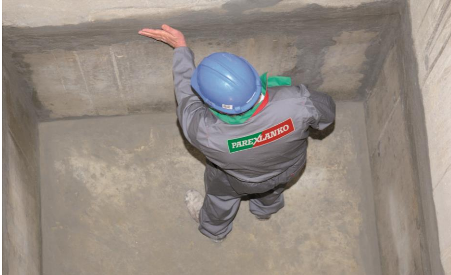
Travaux de cuvelage d'une cage d'ascenseur avec 227 LANKO IMPER FLEX de Parexlanko
