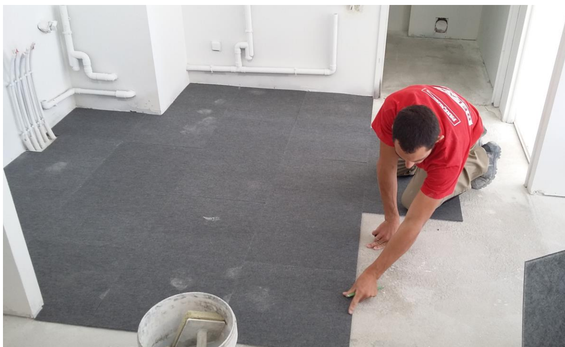
Parexlanko – Mise en œuvre du système d'isolation phonique 586 LANKOPHONIC PLAK +
