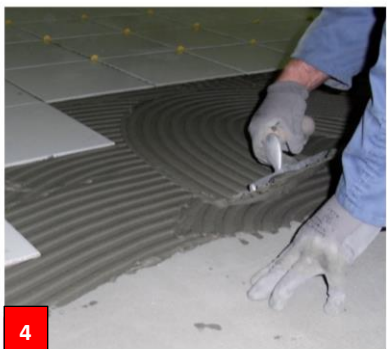
4 Application du mortier-colle avec un peigne demi-lune
