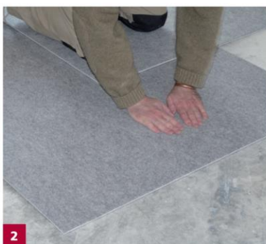
2 Pose des plaques.
