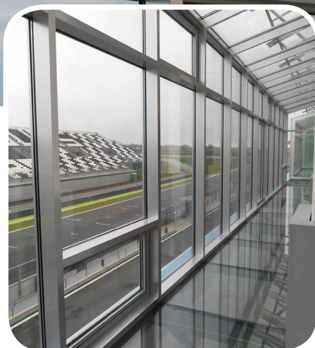
EXUBAIE V2 OS au circuit F1 de Magny-Cours Intégration en façade mur-rideau, ouverture du DENFC vers l'intérieur © Architecte - Jean Bernigaud
