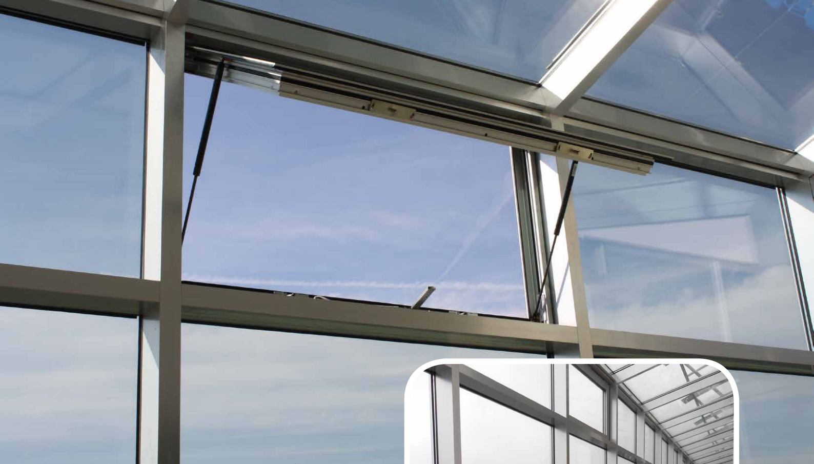
EXUBAIE V2 OS au circuit F1 de Magny-Cours Intégration en façade mur-rideau, ouverture du DENFC vers l'intérieur © Architecte - Jean Bernigaud
