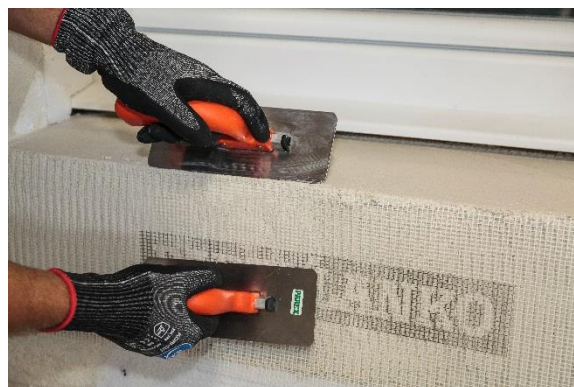
Traitement des points singuliers et mise en œuvre de la finition Calcilisse ParexLanko
