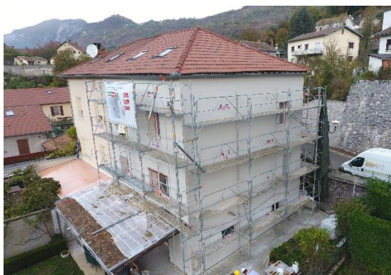
Ravalement et rénovation d'une façade non isolée avec le système ITE Pariso LR-M ParexLanko
